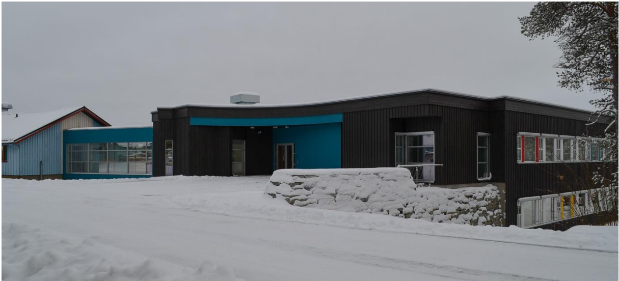
En del av bygningsmassen i Sámi klinihkka, Karasjok.
