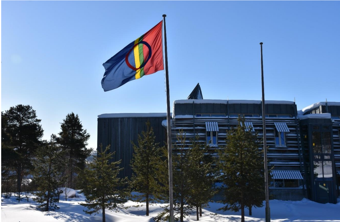
Sametingsbygget i Karasjok med det samiske flagget vaiende en flott vinterdag i nord.
