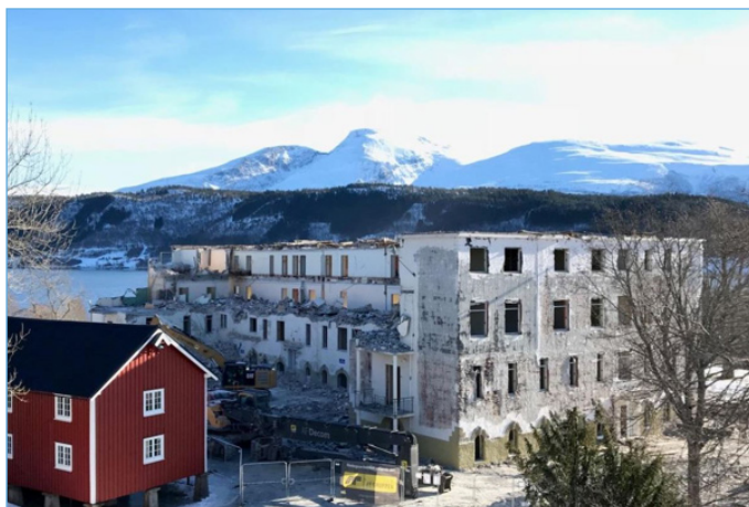
Sjukehuset Nordmøre og Romsdal Riving- og forberedende arbeider. FOTO: Sykehusbygg HF
