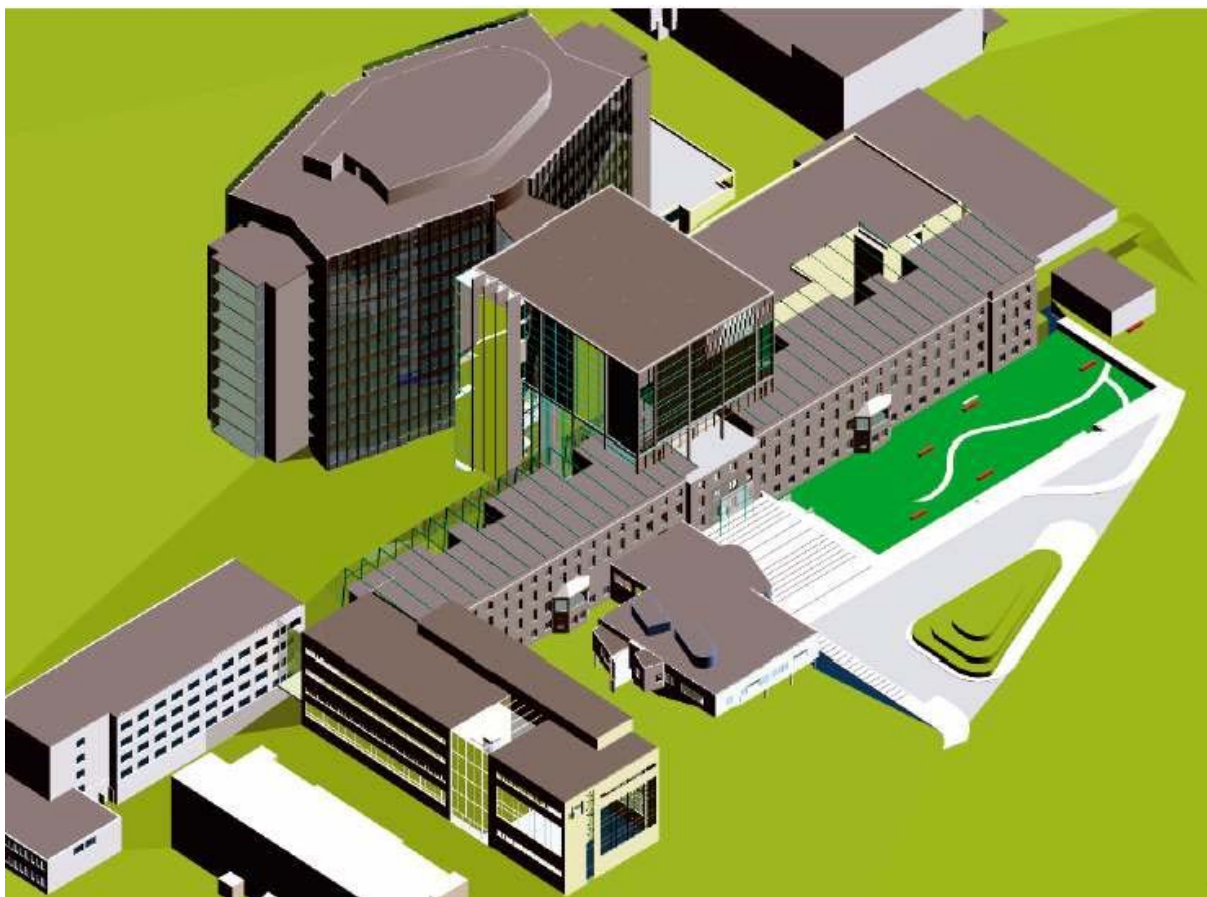
Figur 2: Sykehuset etter fullført modernisering og utbygging
